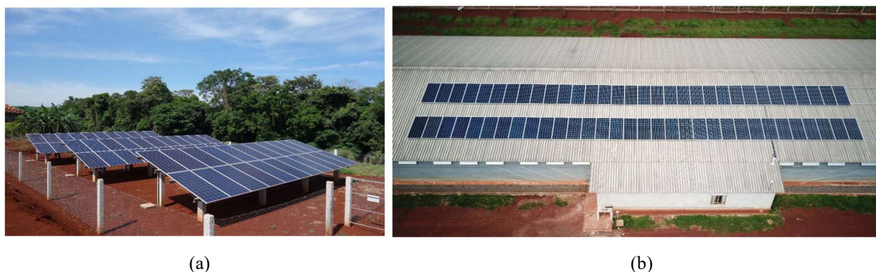
Figura 1 - (a) Arranjo fotovoltaico instalado em propriedade rural em Cafelândia-PR, com módulos FVs de 325 W_p com células solares de silício multicristalino e em (b) Assis Chateaubriand-PR, com módulos FVs de 340 W_p com dispositivos de silício monocristalino.
