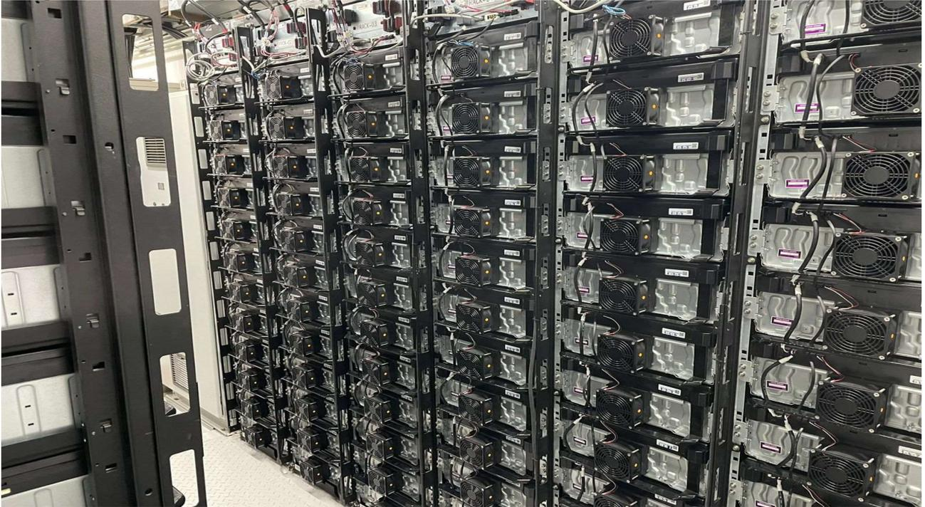
Figura 2 - Disposição física dos módulos de baterias em *racks* no contêiner do BESS.
