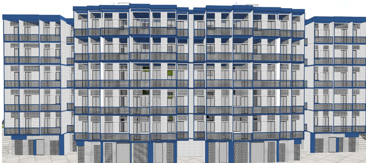
Figura 7 – Condomínio Refazenda – Fachada frontal dos blocos de uso misto
