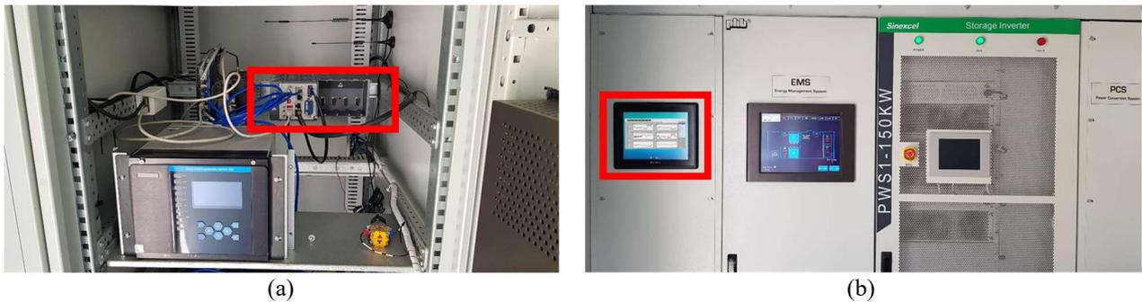
Figura 4 – Infraestrutura de controle do SCAN. (a) Computador industrial. (b) *Touch screen* para interface com o computador industrial dentro do container do sistema de armazenamento de energia.
